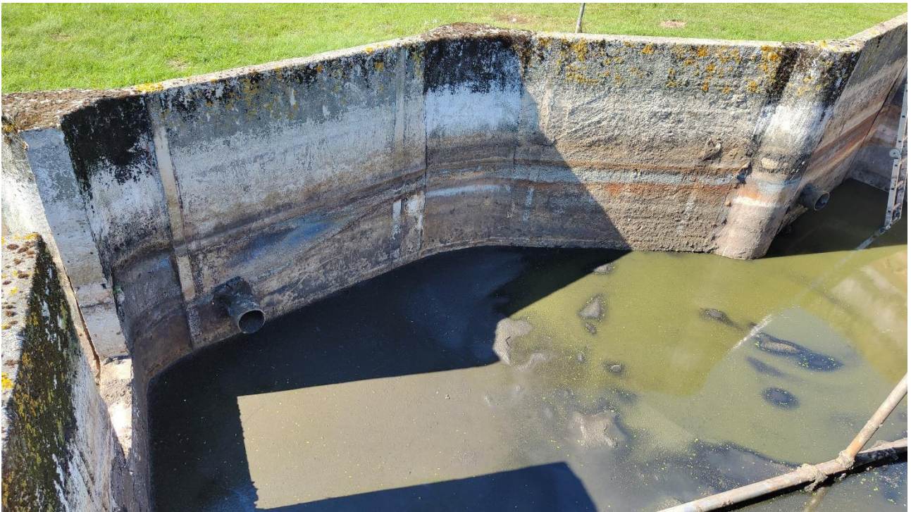
6.1.3. att. Esošās bloku sienas ar atvērumiem.
