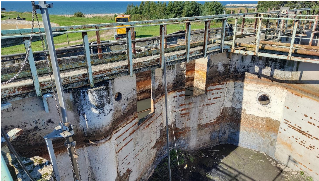
6.1.1. att. Esošās bloku sienas ar atvērumiem.
