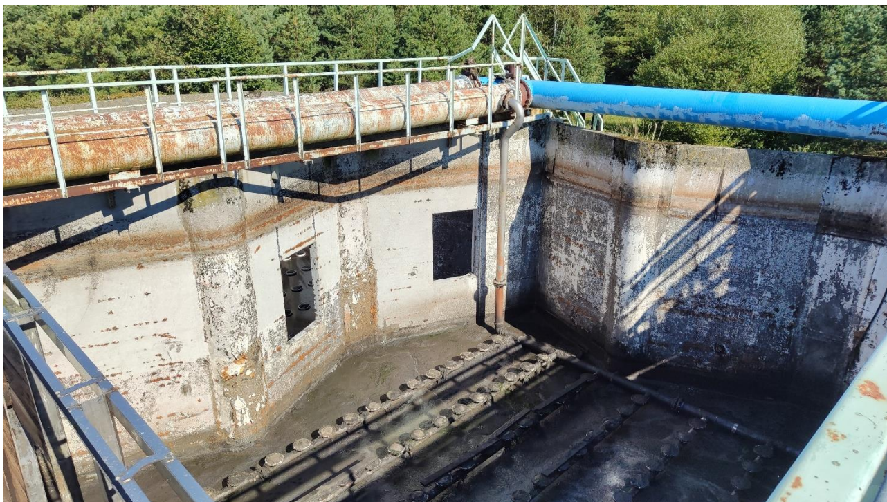
6.1.2. att. Esošās bloku sienas ar atvērumiem.
