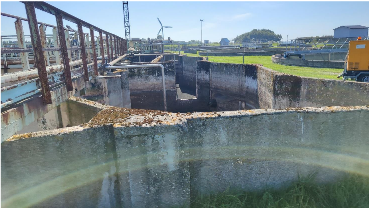
6.1.4. att. Esošās bloku sienas ar atvērumiem.
